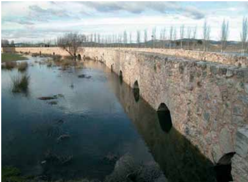
Puente de Villarta de San Juan.
