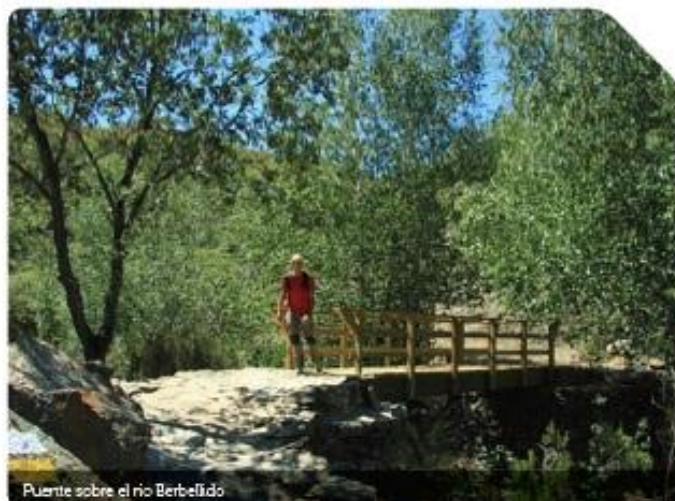
Puente sobre el río Berbelidó
